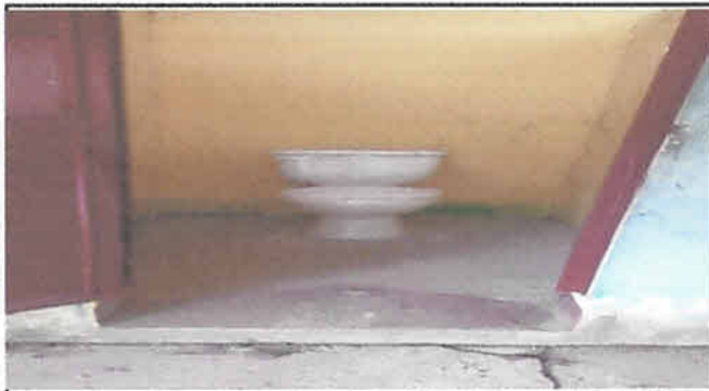
MANTENIMIENTO REMOZAMIENTO DE ESTRUCTURA Y TECHO BAÑO E INSTALACION DEL BAÑO
