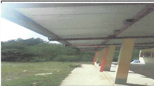
FINALIZACION DEL REMOZAMIENTO DEL TECHO Y MANTENIMIENTO DE LA ESTRUCTURA
