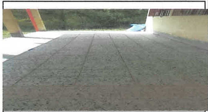
CAMBIO DE PISO FINALIZADO
